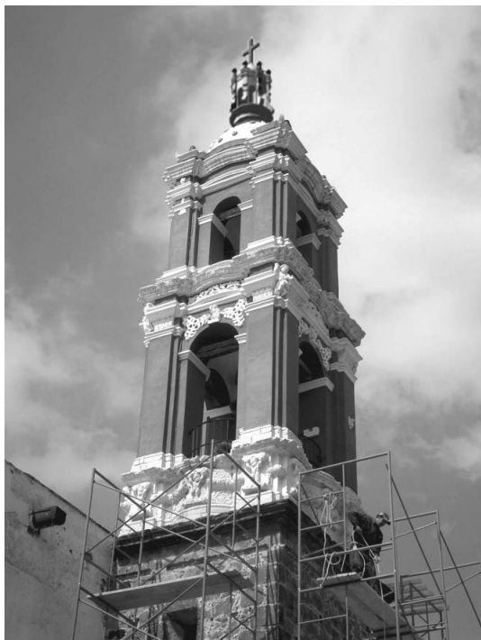
Figura 4. Fotomontaje de linternilla y cupulín como propuesta de reintegración. Imagen de autor.
